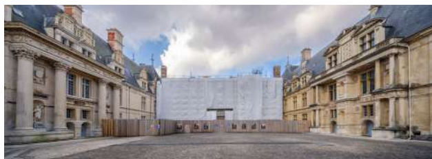
📍 Chantier de restauration des façades au Château d'Écouen
