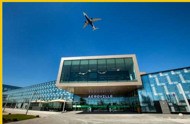
Centre commercial Aéroville
